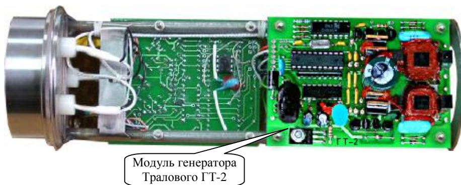
Шасси тралового блока СИ-110 с модулем ГТ-2
